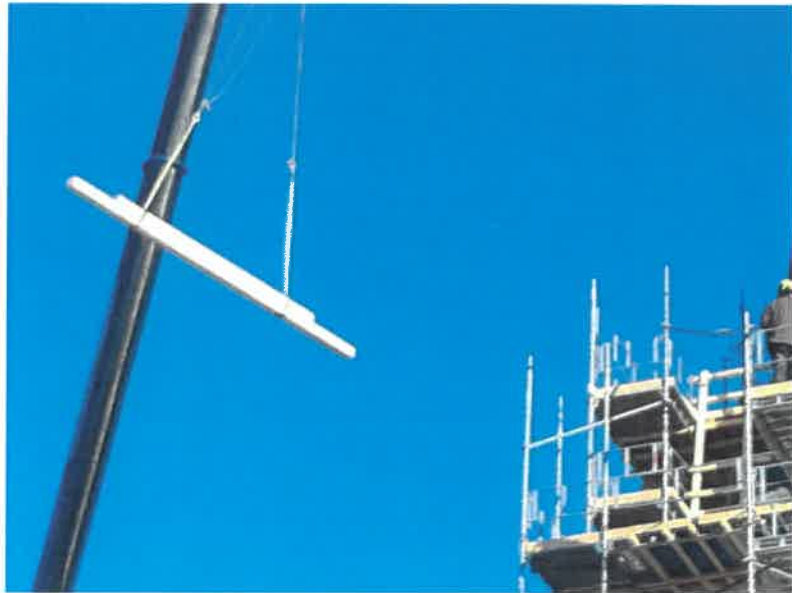
Oppheising av nye emner til tårnsperrer med mobilkran.
