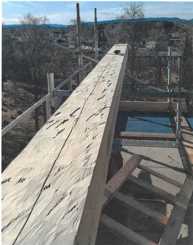
Ny sperre til tårntaket: Nye materialer tilsvarende de opprinnelige. Her er sperreemnet grovtelgjet med øks ned til riktig dimensjon.
