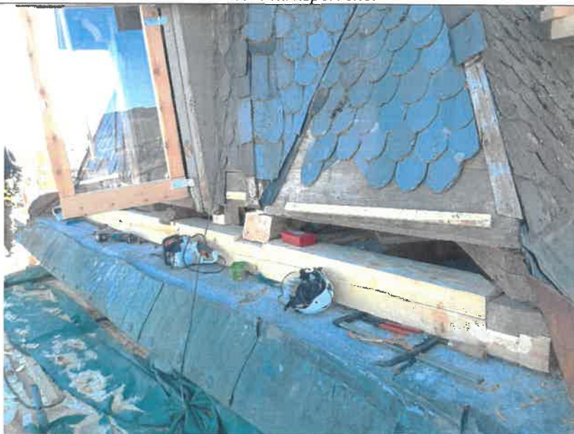
Eksempel på reparasjon med innlegg av ny bunnsvill og nye sammenføyninger med detaljer som ikke er skadet. Her er øvrige sammenføyninger til en viss grad løsnet, og tårnet jekket opp slik at lasten er lettet fra bunnsvill og sammenføyninger.
