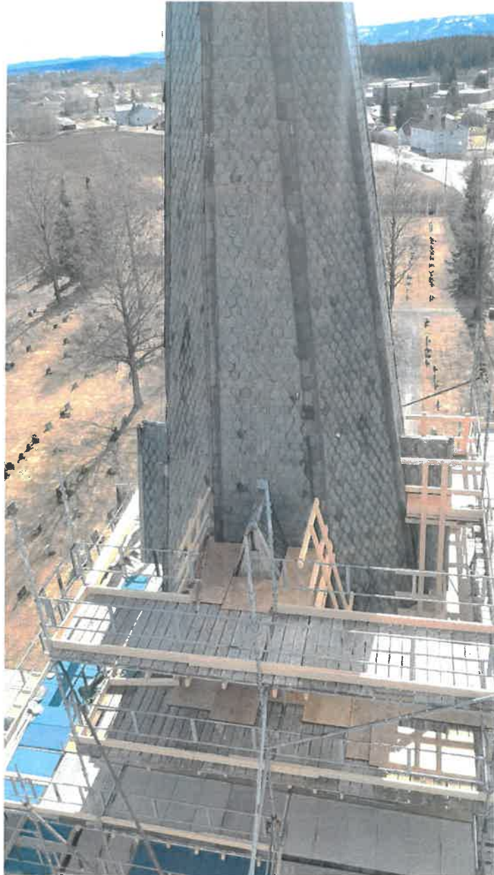
Tårnet og arbeidsplattformene bygget inntil tårntakets spissgavler, sett ovenfra.
