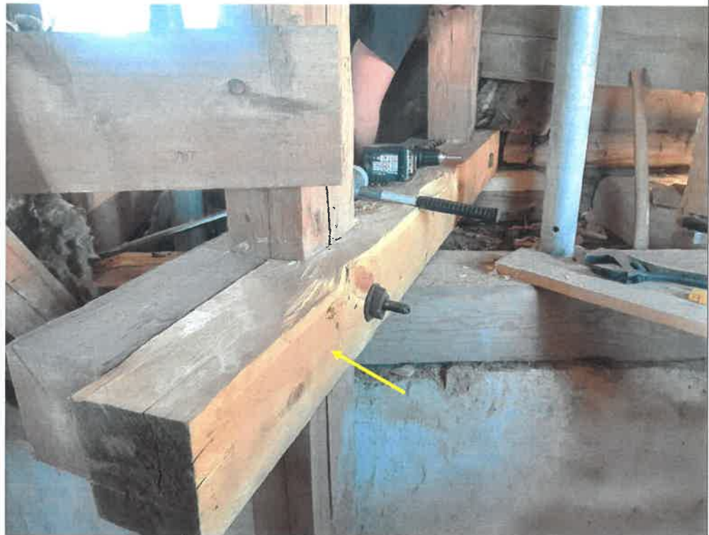
Strekkbjelken som forbinder ytre og indre tårnsperre, er her skiftet ut i sin helhet.
