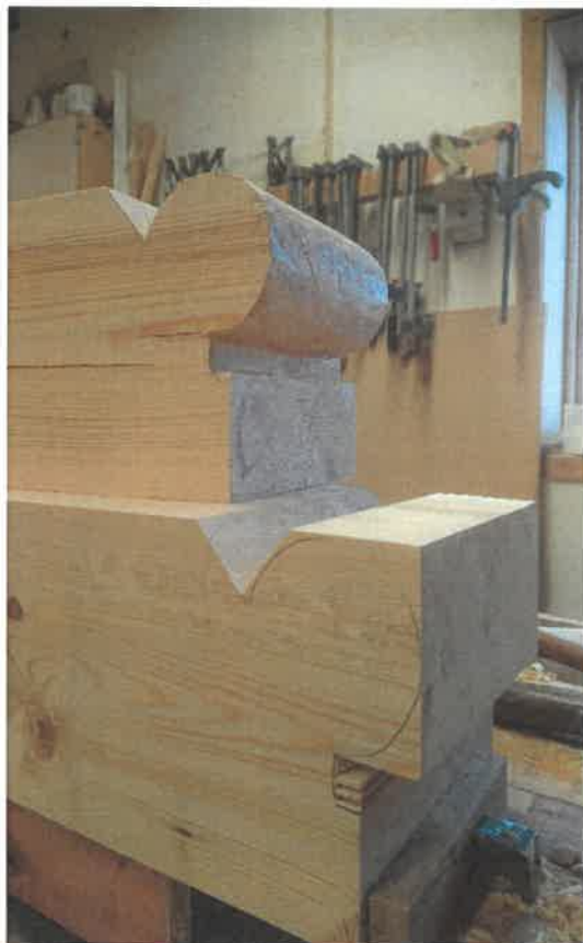
Blindsperrer med profilerte utstikk, til spissgavlene over lydgluggene.
